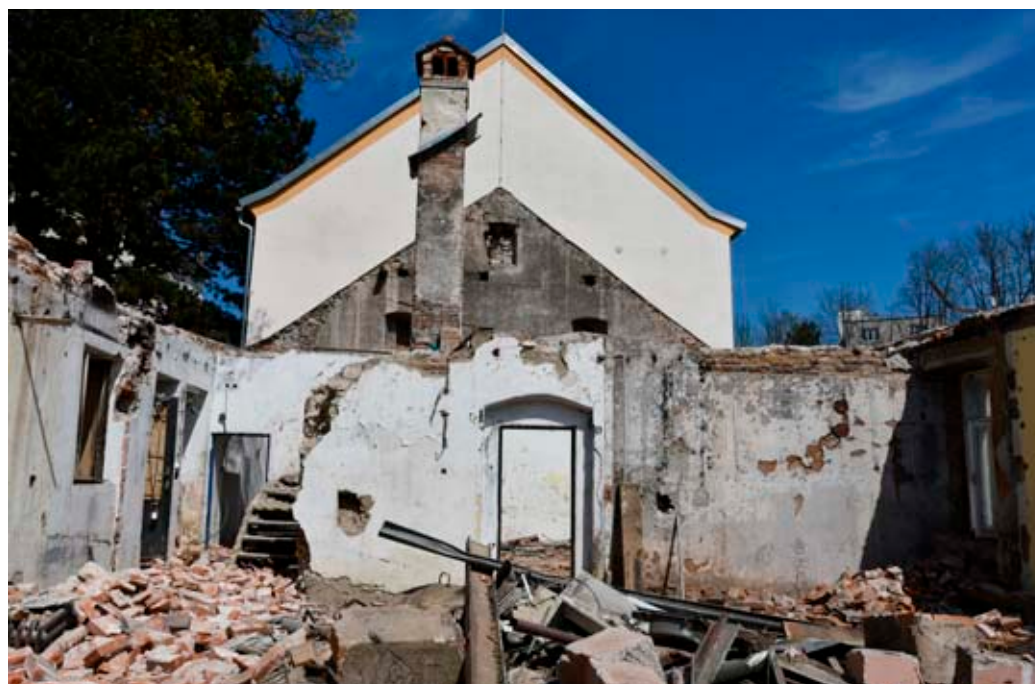
Dělníci již odstranili střešní krytinu a krovy.
