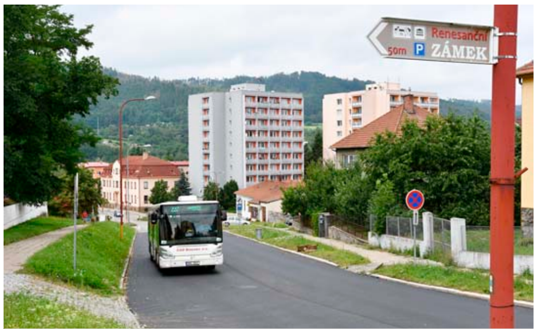
Rekonstrukce Dvorské ulice trvala asi čtrnáct dnů.
