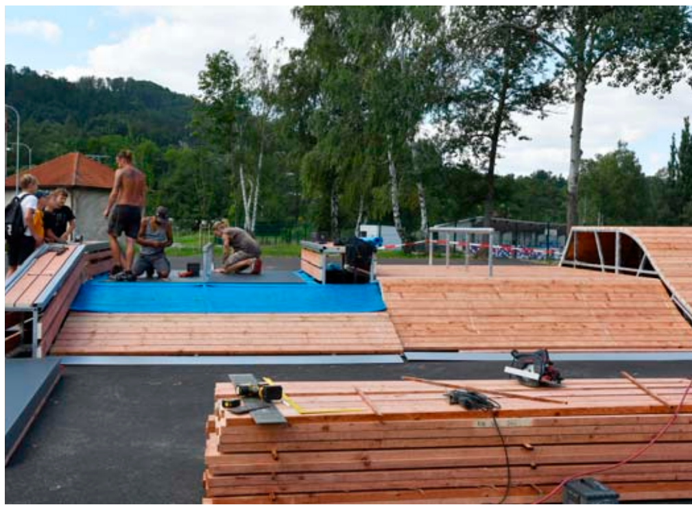
Ve skateparku začala instalace nových překážek. Nové prvky nahradí ty původní, které už nevyhovovaly současným bezpečnostním předpisům. Ještě před osazením překážek dostal skatepark nový asfaltový povrch. FOTO: Pavla Komárková
