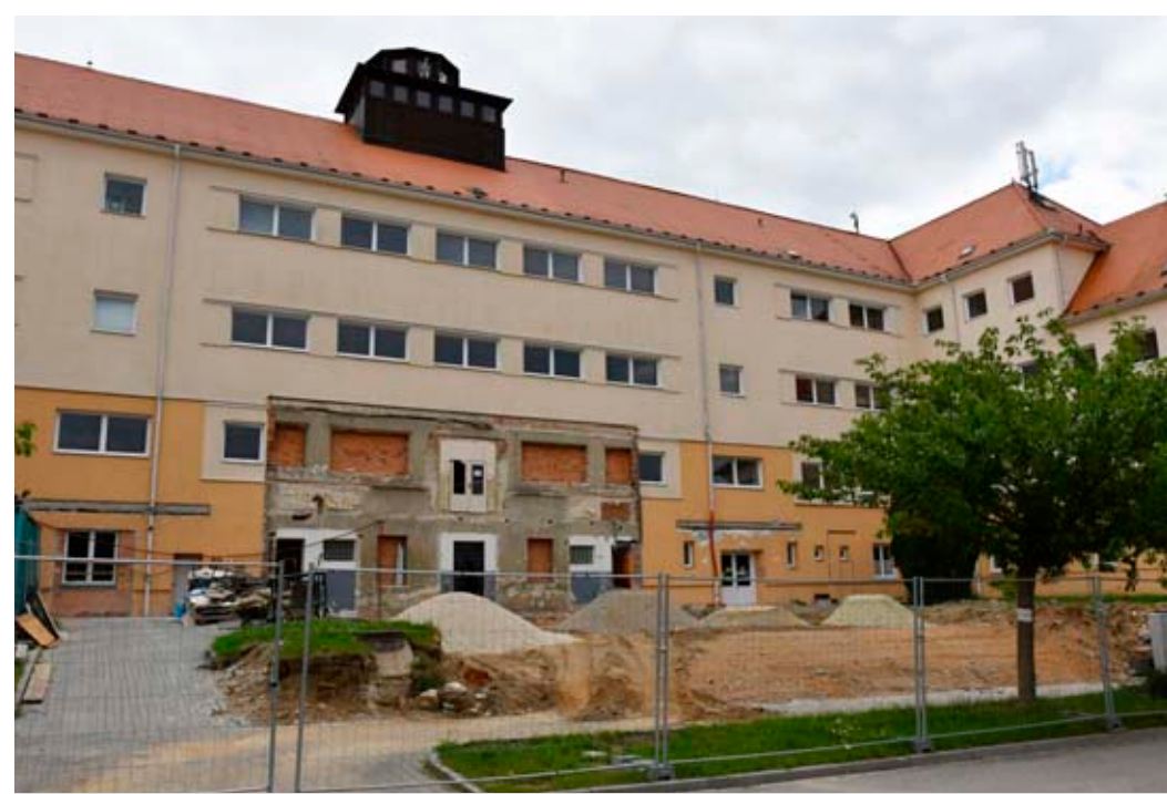
Budovat se teď bude nový vstup do školy.
