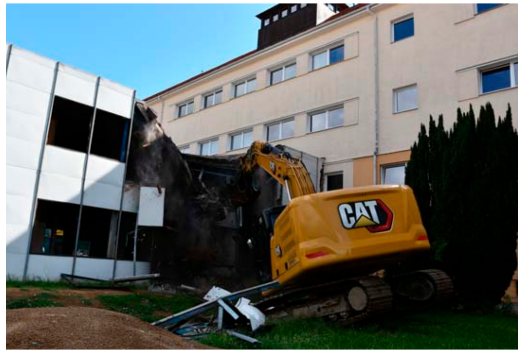
Demolici přístavby prováděl pětadvacetitunový bagr.
