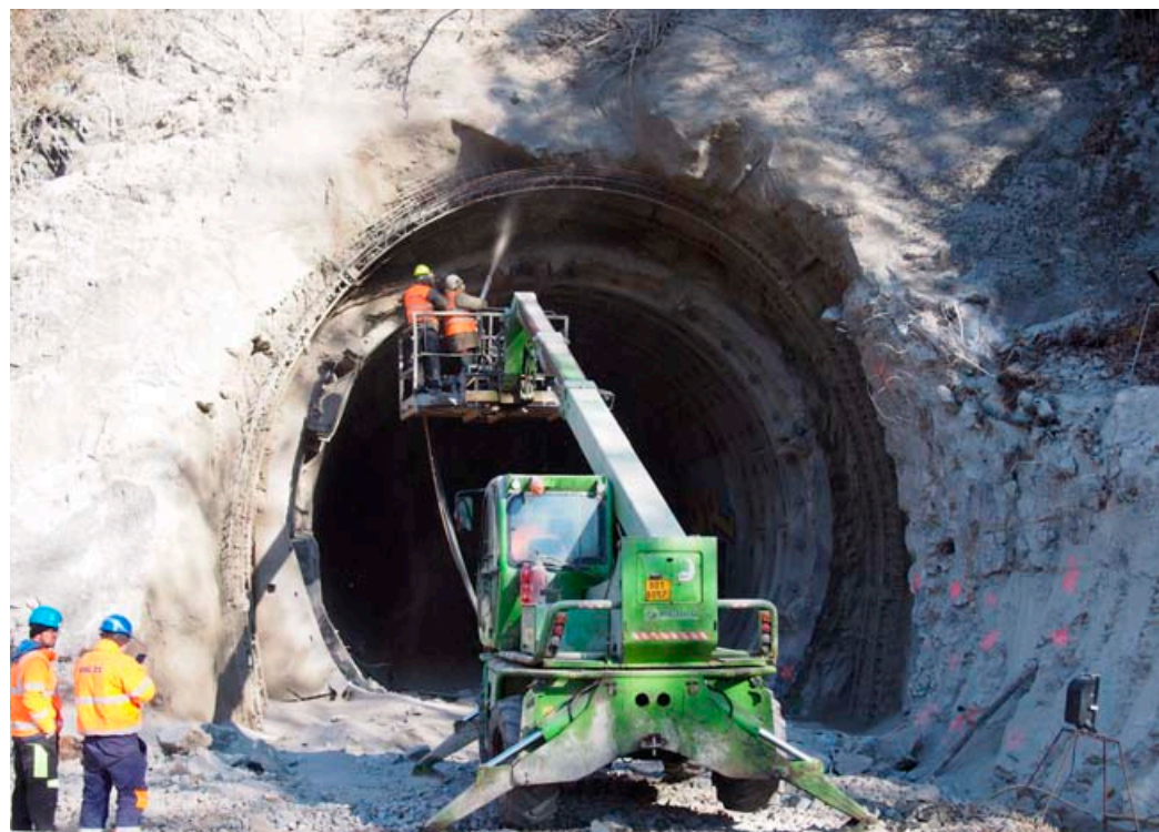
V současnosti se pracuje na sanaci tunelů.
