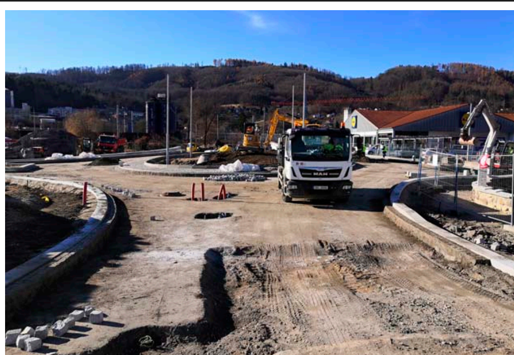
Stavba kruhového objezdu u Penny marketu finišuje. Průjezdny pro motoristy by měl být 1. prosince, další dva týdny se budou ještě dokončovat chodníky a terénní úpravy. Dál pokračují i práce na přemostění na Staré Blansko, hotová je z velké části opěrná zeď, pokračuje stavba mostních opěr na obou březích Svitavy. Hotovo by mělo být v říjnu 2022. FOTO: Michal Záboj
