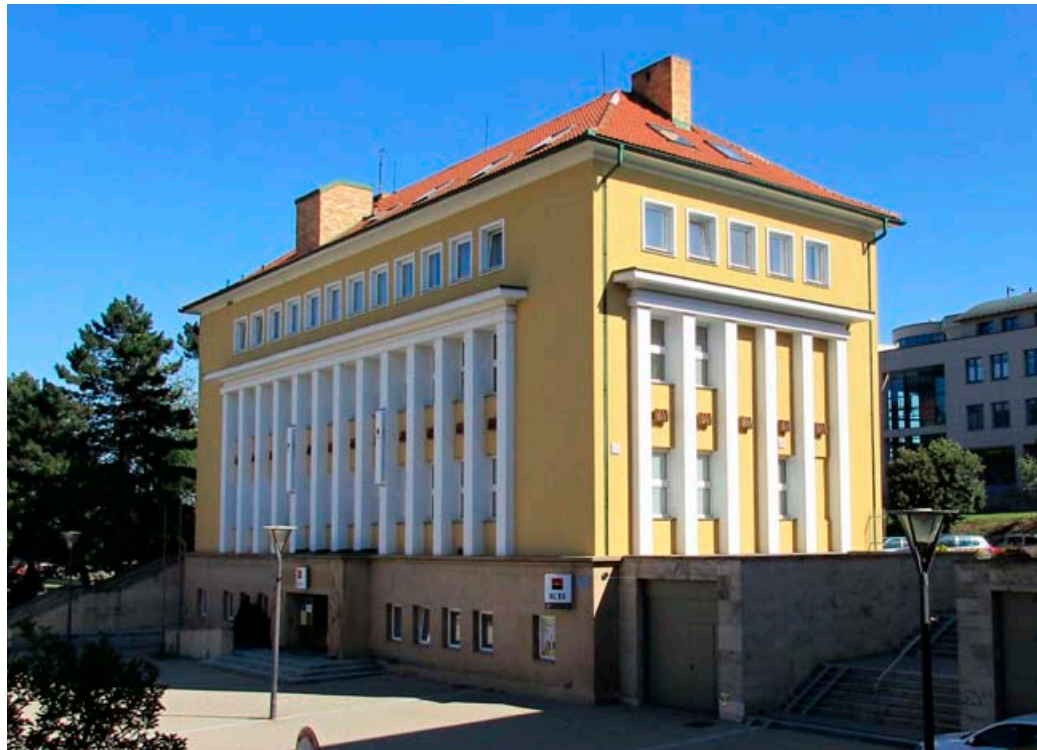
Pohled na východní stranu budovy banky .
