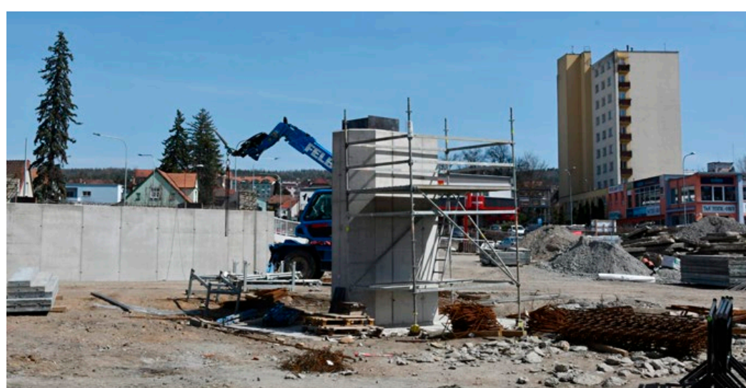
Na stavbě přemostění se pracuje devět měsíců.
