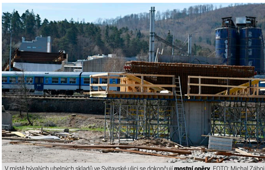
V místě bývalých uhelných skladů ve Svitavské ulici se dokončují mostní opěry. FOTO: Michal Zábaj
