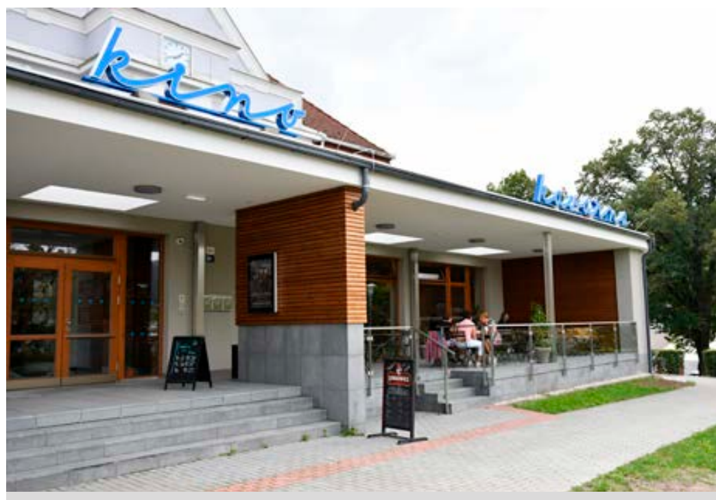
Po opravách má kino i kavárna zastřešený vstup.
