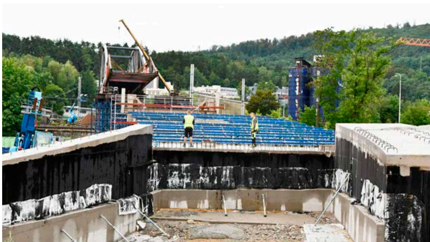
Dělníci vysunuli nový most přes železnici a řeku Svitavu.
