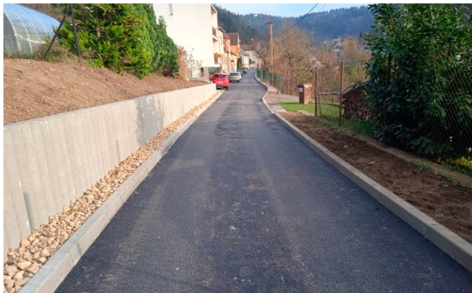
Oprava zahrnovala obnovu opěrné zdi . Foto: Sylva Vágnerová
