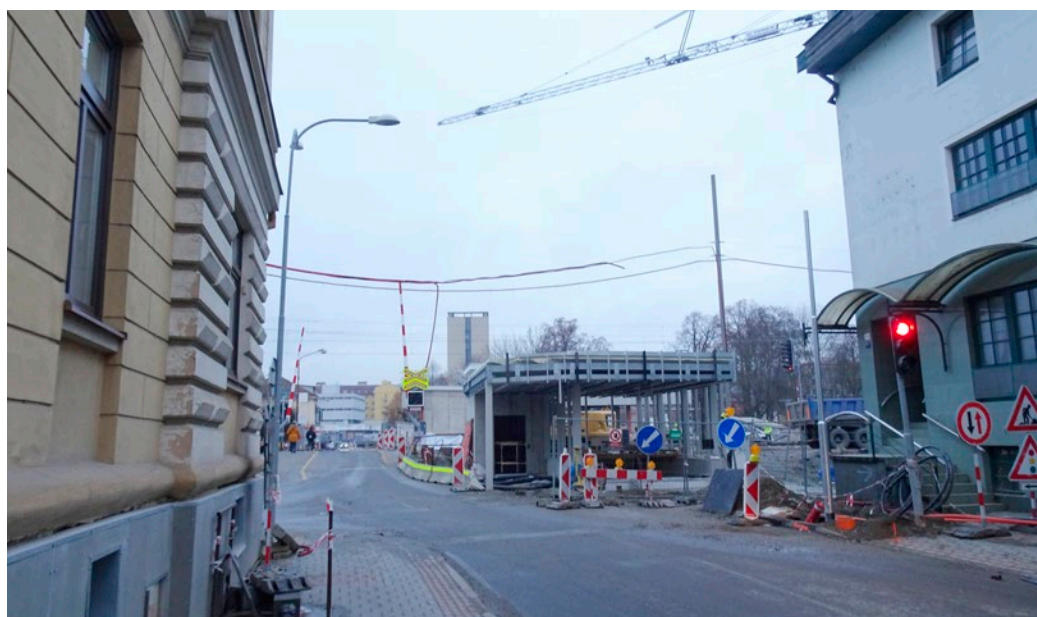
U vlakové zastávky Blansko-město finišuje stavba nového podchodu. FOTO: Tomáš Žák
