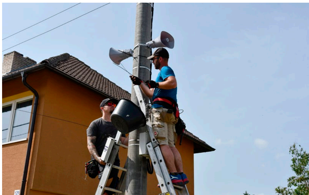
Pracovníci firmy instalovali hlásiče v Dolní Lhotě.
