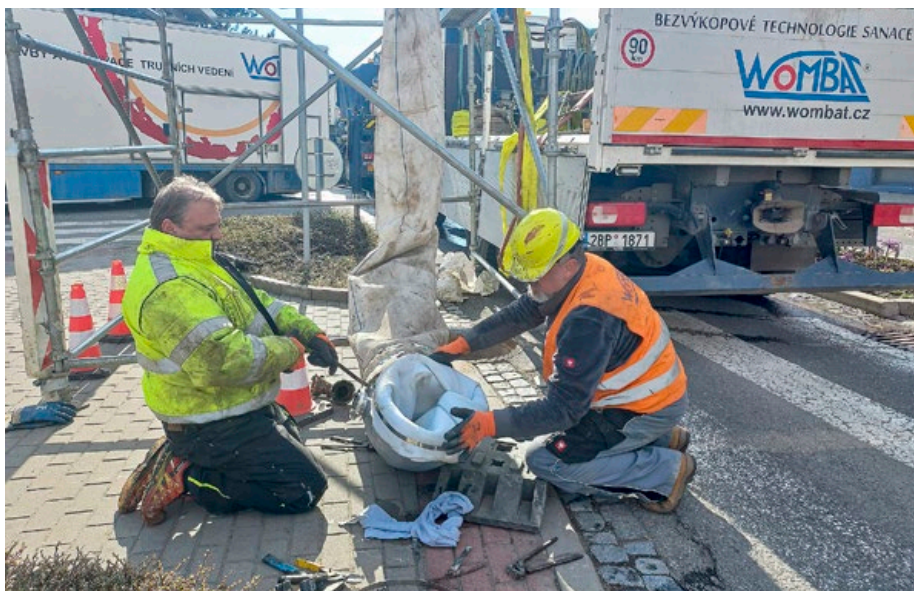
Dělníci opravovali kanalizaci ve Smetanově ulici.
