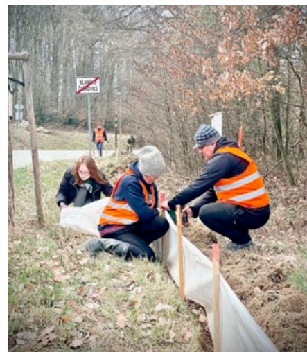
Obyvatelé Češkovíc se zapojili do stavby žabích zábran podél silnice.
