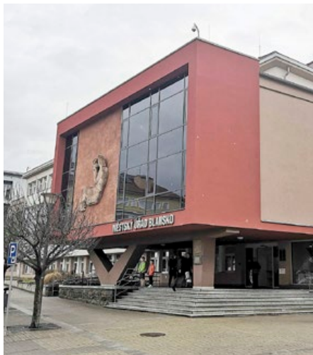
Rekonstrukce čeká horní patra budovy MĚÚ na náměstí Republiky.
