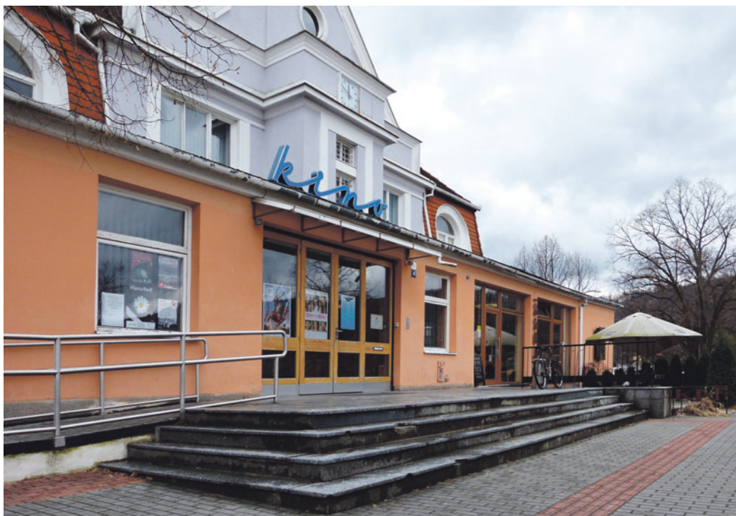
Kino i kavárna dosud mají dva vlastní vchody. To se ale v létě změní. Opravou projde i zastaralé schodiště. Foto: J. Franchi
