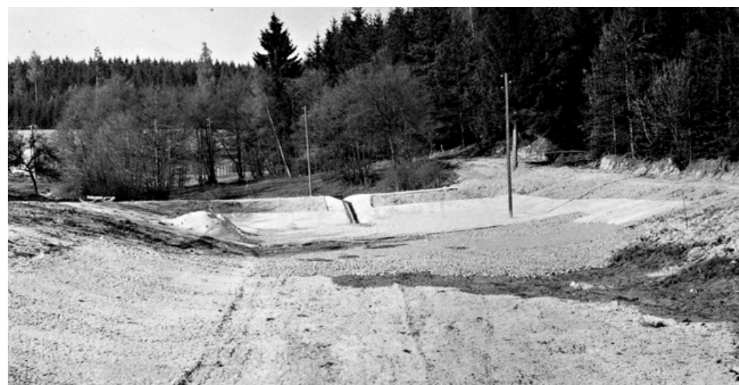
Hráz rybníka Na Lopatě, kterou poškodila velká voda, byla opravena v roce 1971.
