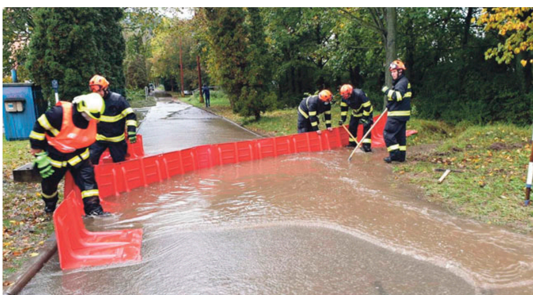
Profesionální hasiči a dobrovolní hasiči z Obůrky ve středu 14. října zasahovali u rozvodněného potoka Sloupečnick. Na místě postavili mobilní protipovodňové zábrany. FOTO HZS JMK.
