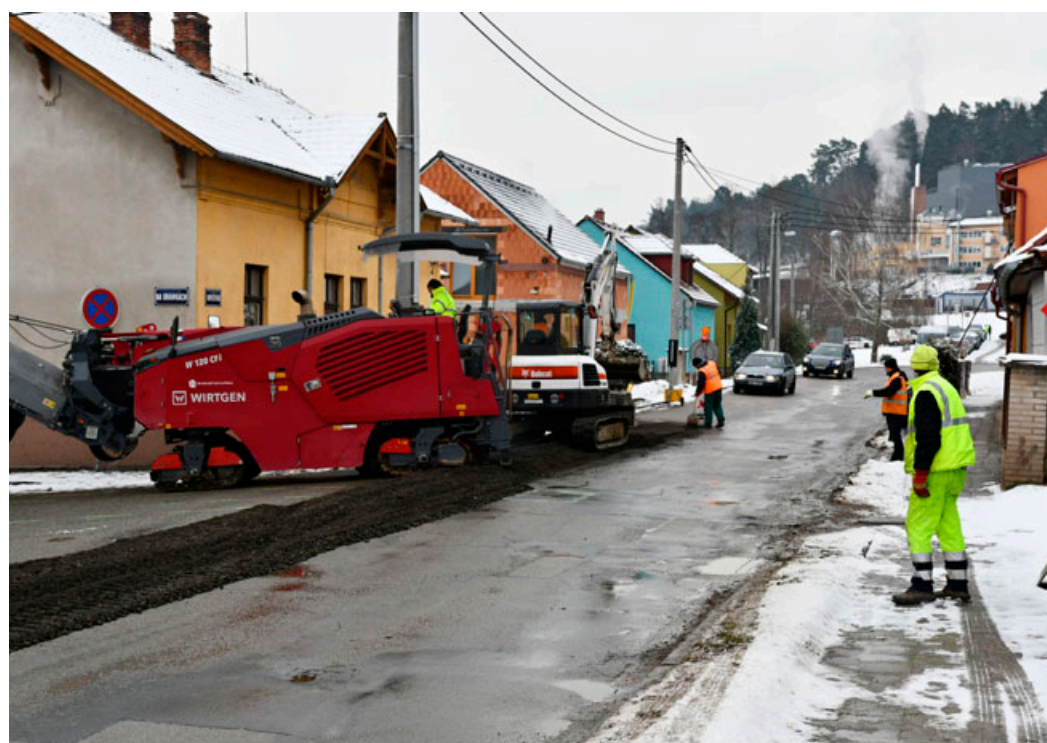
Opravy Brněnské začaly v úseku křižovatky s ulicí Na Brankách.
