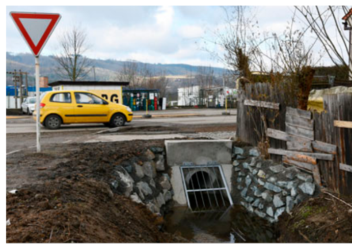
Dělníci upravili vtok potoka do zatrubnění. FOTO Michal Zábaj
