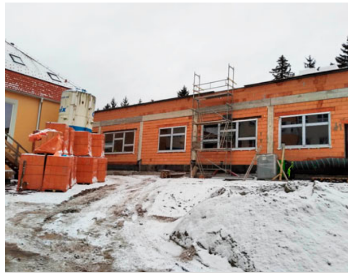
Práce probíhají uvnitř přízemní budovy budoucí jídelny a kuchyně. FOTO Leona Mazourková
