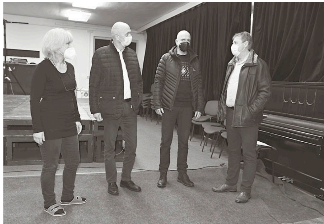
Blansko navštívil radní Jihomoravského kraje pro investice a majetek Vladimír Šmerda. Prohlédl si budovu Základní umělecké školy Blansko na Kollárově ulici, ve které také působí Divadlo Kolárka. Objekt je v havarijním stavu. Radní přislíbil, že se začne pracovat na projektu rekonstrukce budovy. (zleva Eva Petrželová, Jiří Crha, Jiří Žerníček a Vladimír Šmerda) FOTO Michal Zábaj
