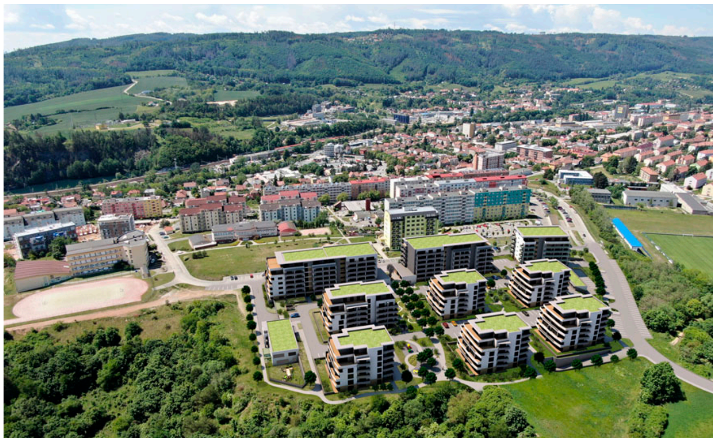
Nové byty na Písečné vyrostou na pozemcích města i soukromých majitelů.
