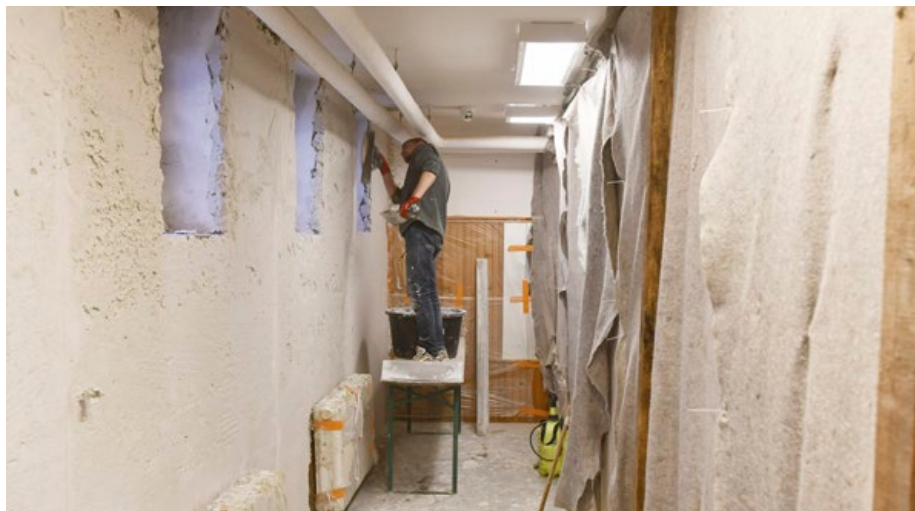
Vnitřní prostory haly dostanou sanační omítky.
