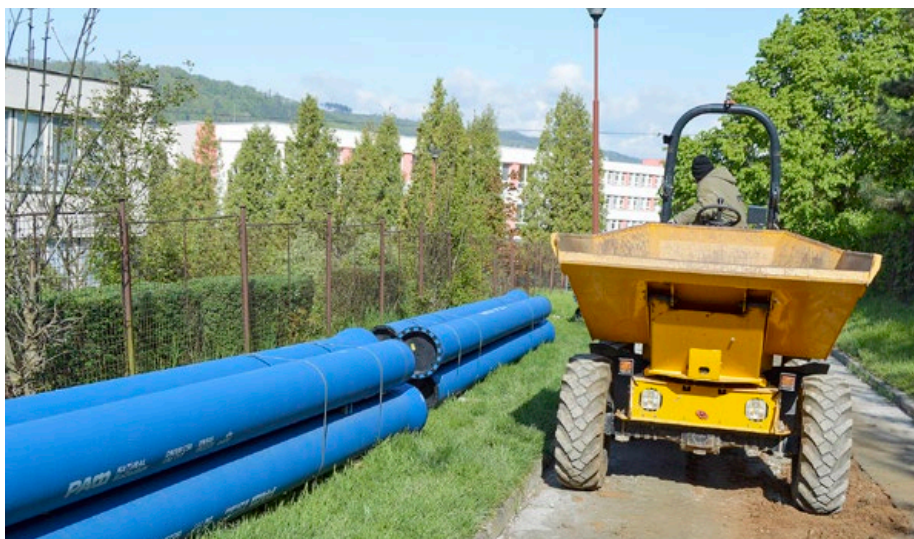
Stavební práce ve Dvorské ulici dočasně omezí pohyb chodců a vozidel.
