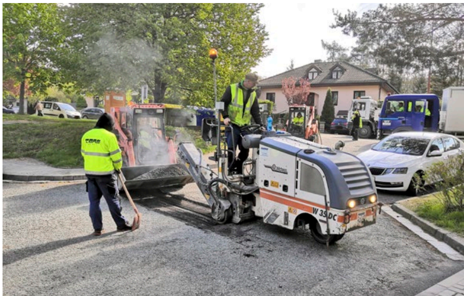
Opravy výtluků zahájili dělníci na sídlišti Zborovce.
