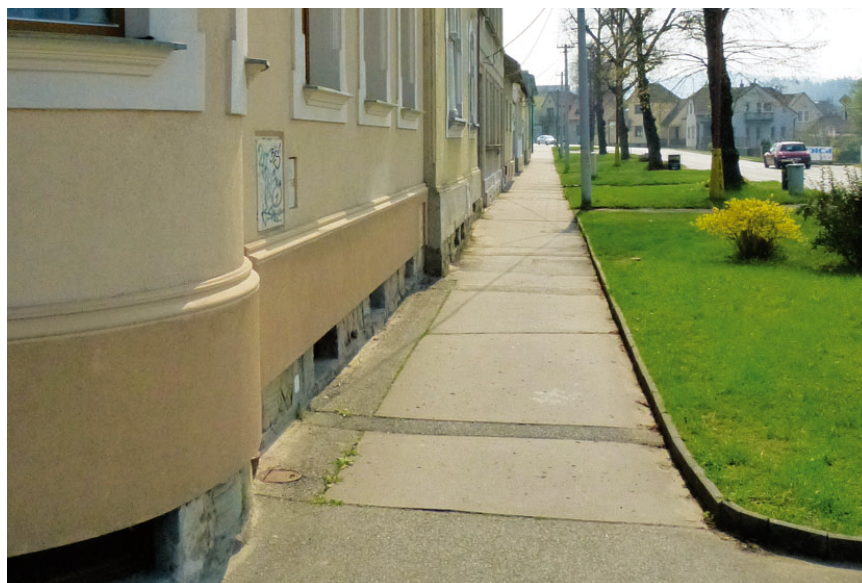
Asfaltové chodníky na Masarykově ulici projdou letos rekonstrukcí. Foto: J. Franchi
