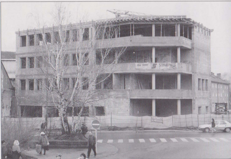
Stavba IPB a městské knihovny na Rožmitálově ulici.
