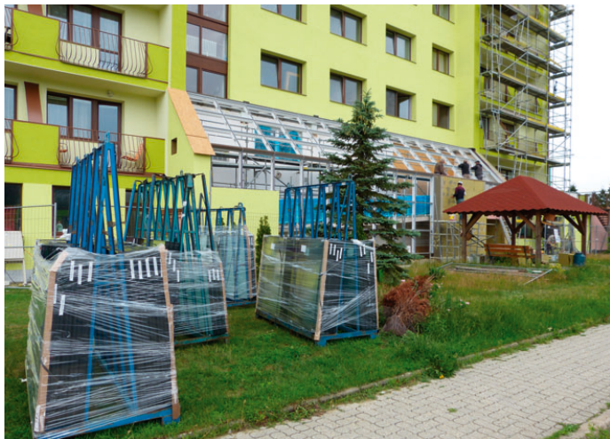
Do prázdnin potrvá rekonstrukce budovy Domu s pečovatelskou službou v sídlišti Písečná. Foto: J. Franchi
