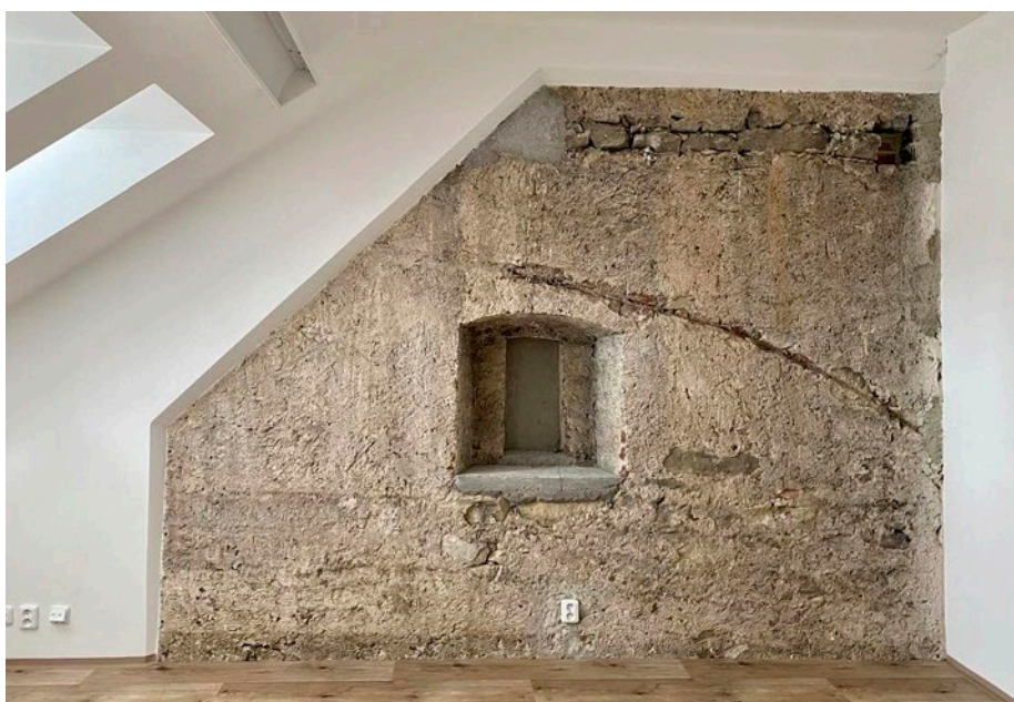
V interiéru architekti zachovali původní zdivo.
