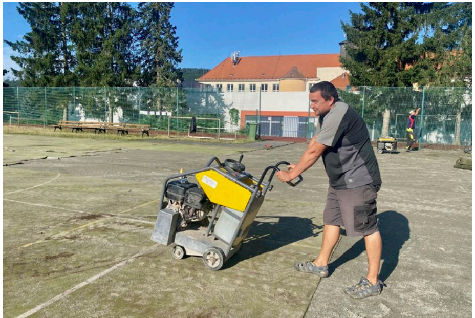
Oprava hřiště u ZŠ TGM.
