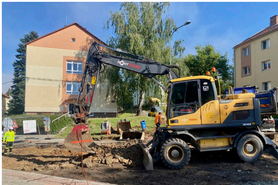
Opravuje se část od ulice 9. května po sportovní halu.
