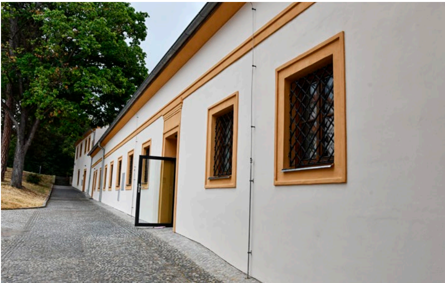
Opravená fasáda ladí s okolními budovami.
