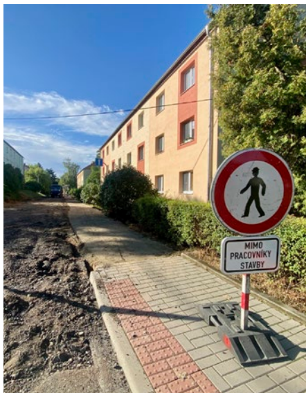
Do opravované části Údolní ulice je zakázán vjezd vozidel i vstup chodcům. FOTO: Pavla Komárková
