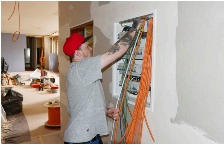
V Dělnickém domě nyní probíhá výměna elektroinstalace. FOTO: Renata Spotzová
