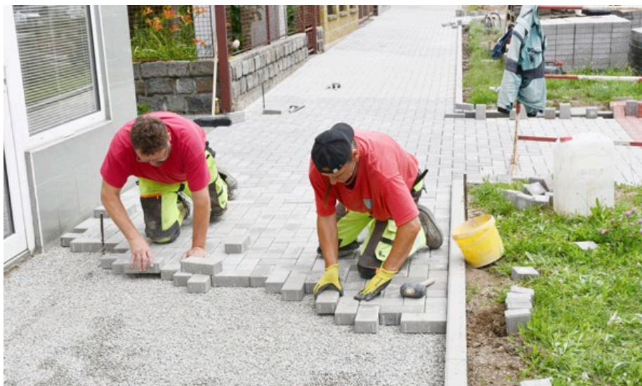
Dělníci dokončili dláždění na jedné straně Mlýnské ulice.
