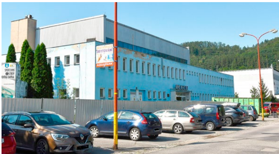
Budovu lázní obepnulo oplocení.
