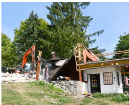
Dělníci zbourali objekt původního občerstvení a toalet. FOTO: Michal Záboj
