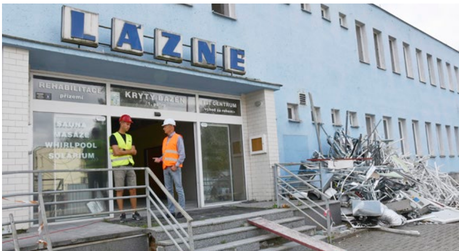
Starostu Jiřího Crhu (vpravo) seznámil s přípravami na demolici lázní hlavní stavby budoucí Martin Mičoch. FOTO: Pavla Komárková
