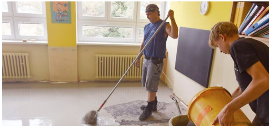
V jedné z místností bylo nutné vylít novou podlahu.
