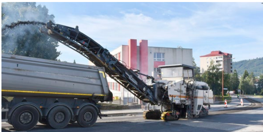
Frézování vozovky ve Dvorské ulici.
