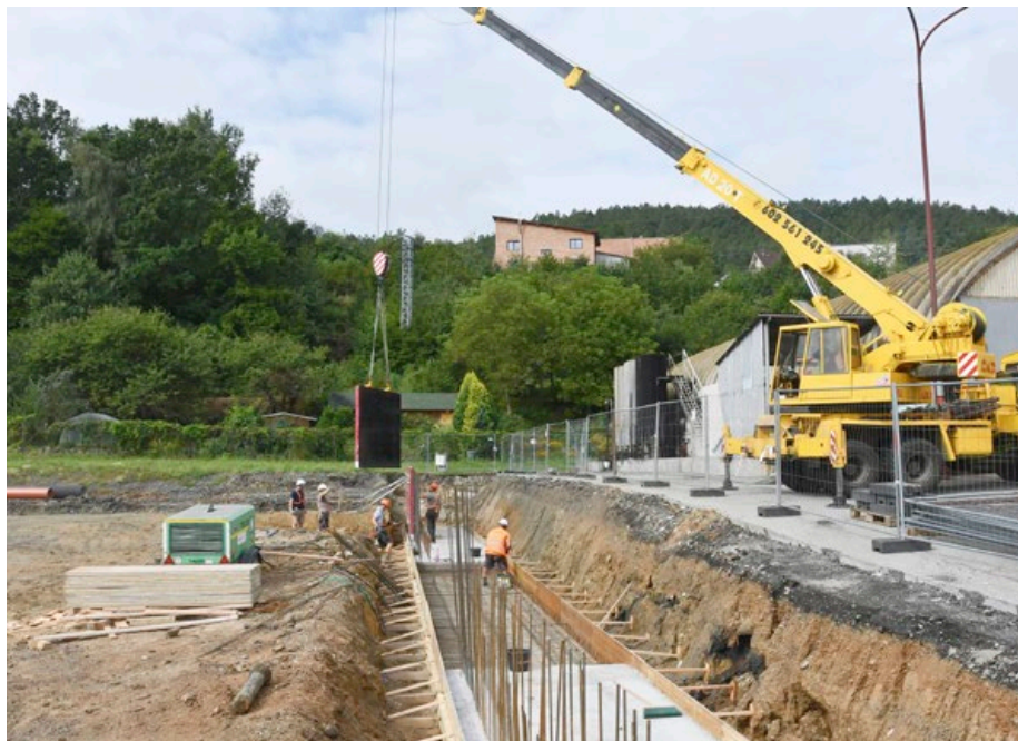
V areálu SÚS v Blansku začala stavba nové haly.
