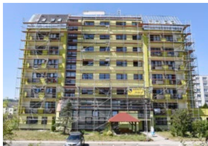
Oprava střechy začala na východní straně budovy. FOTO: Michal Záboj
