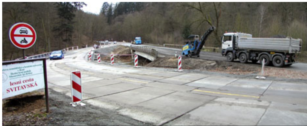
V březnu začala úplná uzavírka v úseku Blansko – Lipůvka u odbočky na účelovou komunikaci směr Adamov podél řeky Svitavy pod Novým hradem. Opravuje se zde most a silniční provoz je převeden obousměrně na provizorní přejezd vybudovaný v těsné blízkosti s opravovaným mostem. Uzavírka potrvá do 31. 7. 2009!
