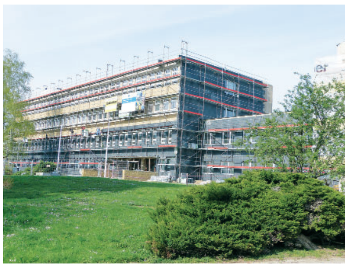
Práce na zateplení budovy ZŠ a MŠ Dvorské byly zahájeny již v květnu.
