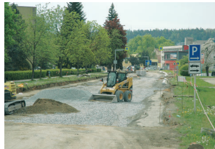
Rekonstrukce ulice Vodní (foceno 9. května).
